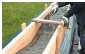
Рис. 3. Надземная часть фундамента дома (опалубка и крепеж)
